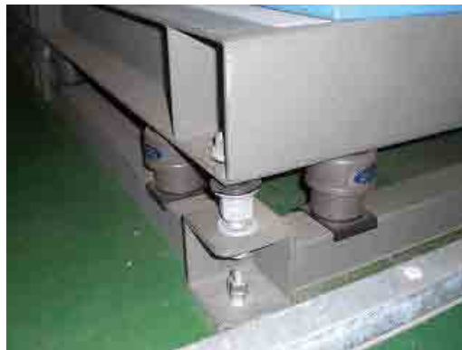
【工場内に設置された大型の機械に対する固定と免震装置の設置状況】
