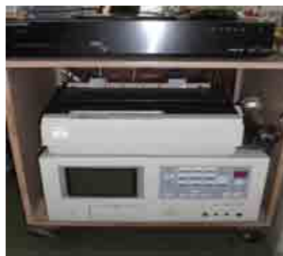
【災害時幹部職員一斉連絡装置】
