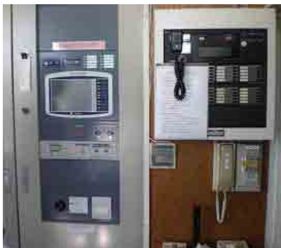
【非常放送設備】
