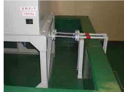
【緩衝装置と防油堤】
