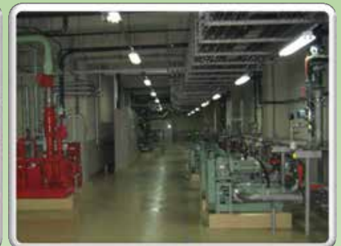
地下ポンプ室
