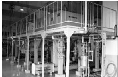
環境衛生センターの基幹的設備 (脱水機)の改修
