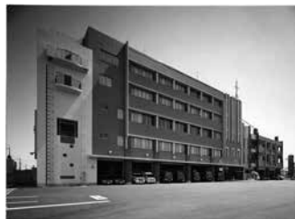
消防局・中消防署
